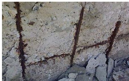
Недостаточная толщина защитного слоя
