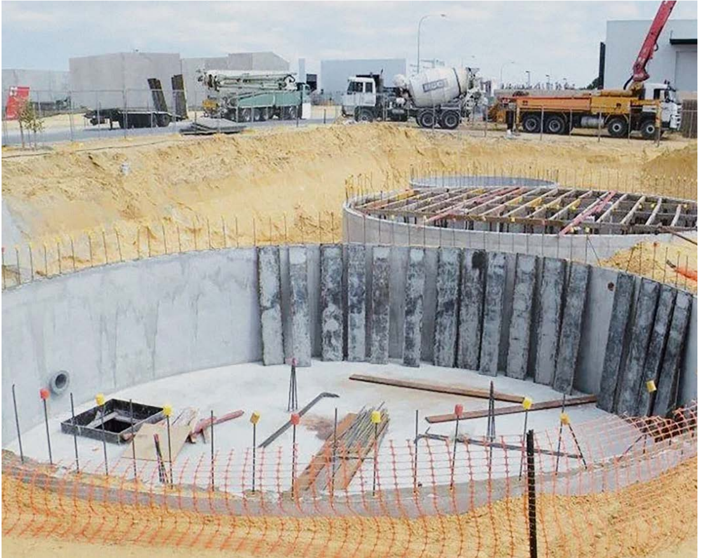
Рисунок 5.2 — Пожарный резервуар
