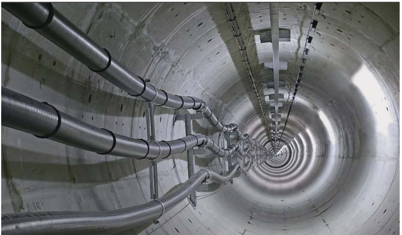
Рисунок 5.4 — Кабельный тоннель
