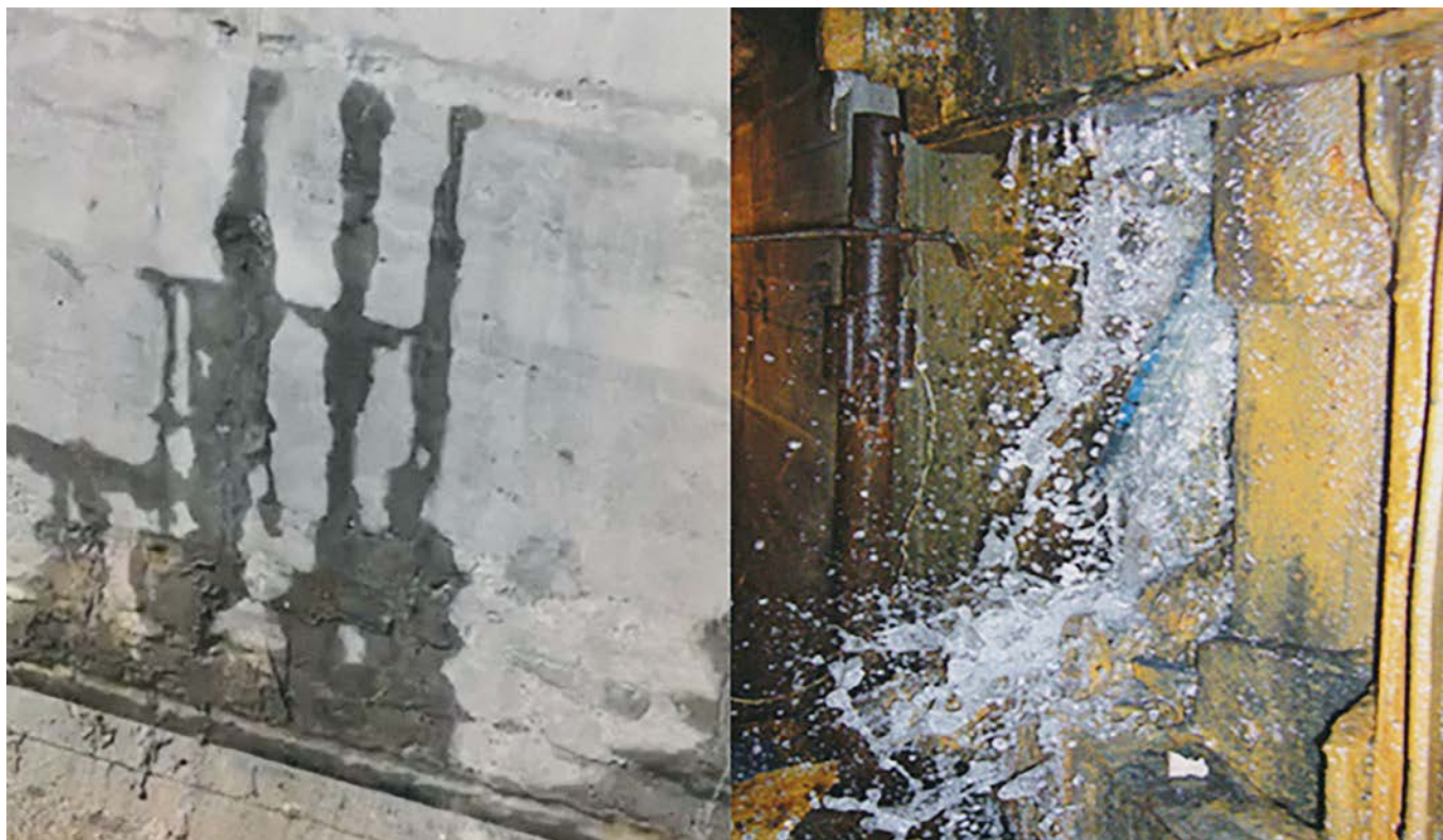
Рисунок 8.2.1 — Безнапорная и напорная течи
