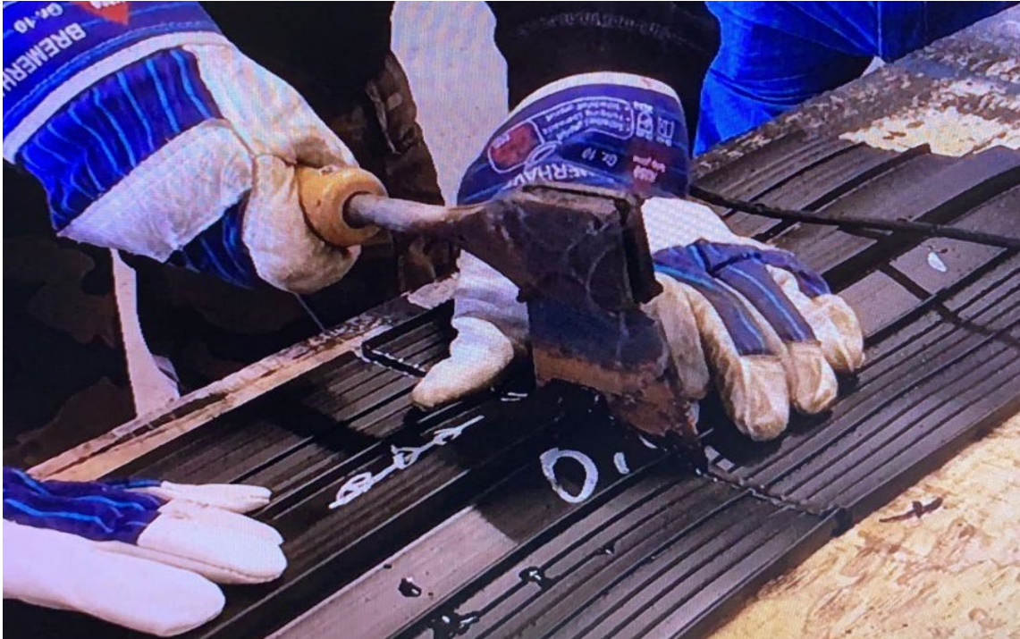
Рисунок 5.4.2 – Пример сваривания гидроизоляционных шпонок при помощи сварочного топора
